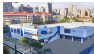
▲集美街基地現場實景照（施工中）。
