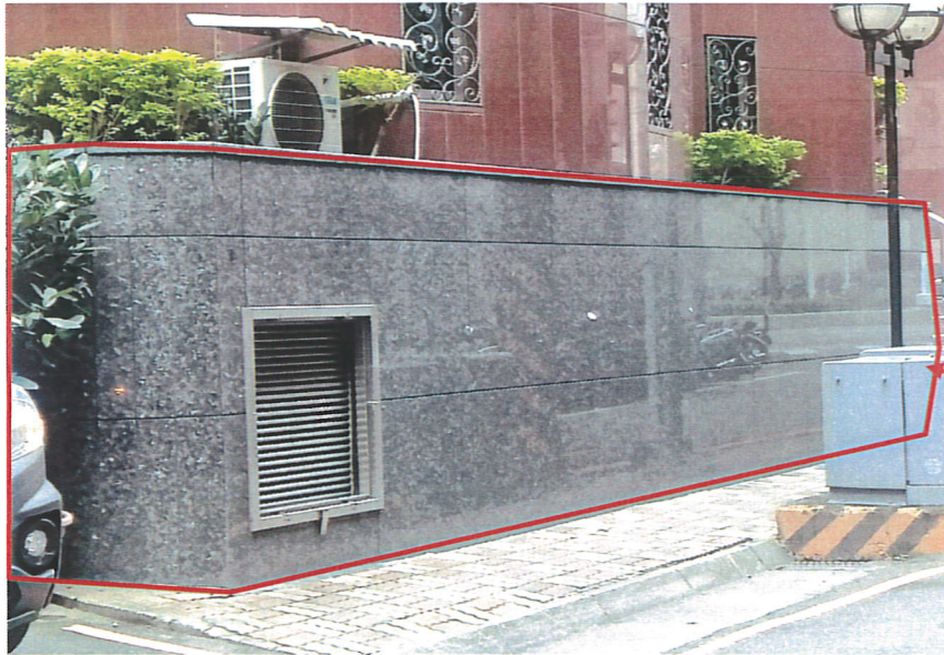
左側花圃紅框範圍內石材外 牆矽利康割除更新 (DOWSIL991 材料)
